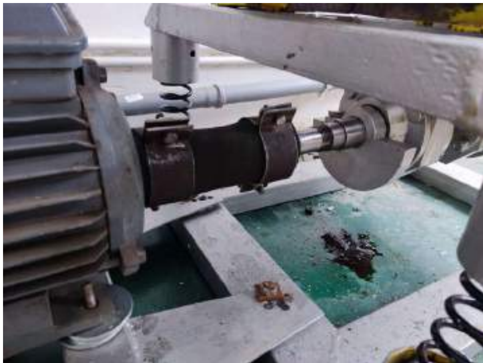
Рисунок 6 – Фото установленной муфты
