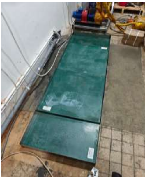
Рисунок 11 – Поддон для предотвращения пролива теплоносителя с установленными в него виброгасящими ковриками
